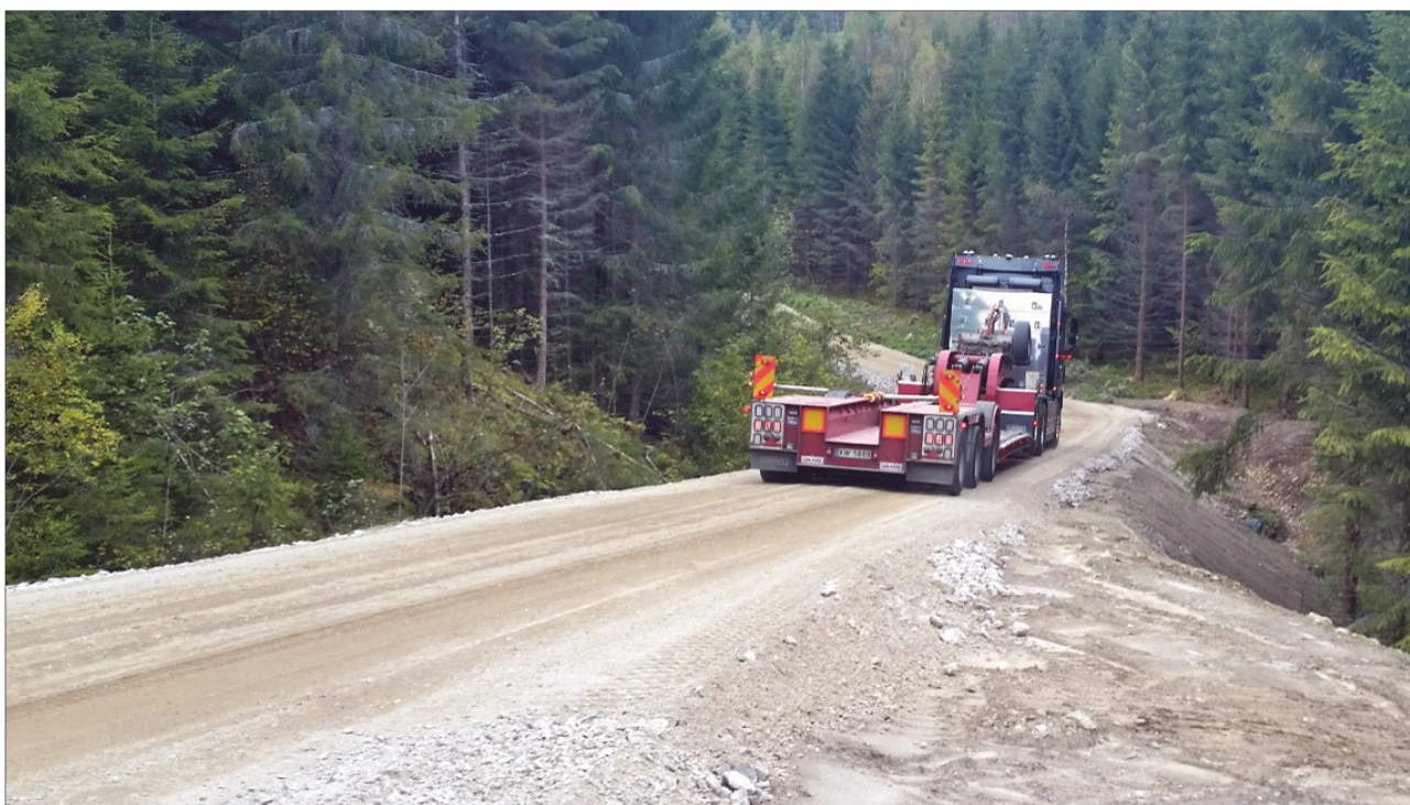
Bilde 2: Det stilles store krav til veistandard for tømmertransport og transport av skogsmaskiner inn og ut til driftsområder. Grandalsveien i Siljan. Foto: Espen Nordstrand
